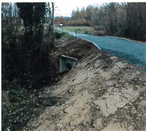
Réparation de l'effondrement d'une voie et de son passage busé. Pont de Lysabel- Saint Cirq Madelon
