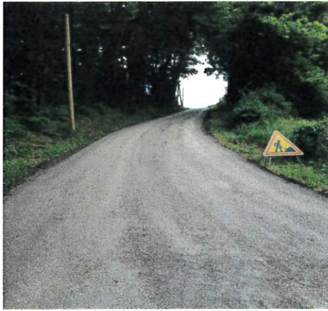
Chantier avec Grave Emulsion avec 30% d'agrégat d'enrobé recyclé
